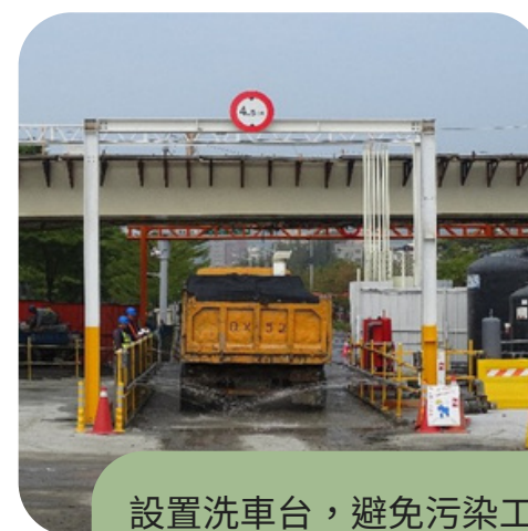
工區出入口及環場動線剛性路面
