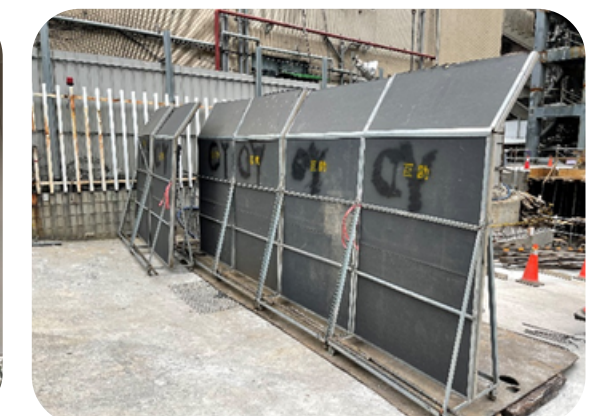
設置降噪設備
