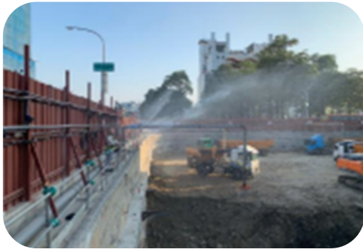
● 設置灑水系統(抑制揚塵、樓板養護)
