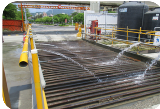
● 工地出入口設置洗車台設備及沉澱池，車輛通行洗車台期間持續噴水，具有防溢座、廢水收集坑、沉砂池、排泥設備。
