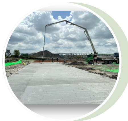
工地臨時動線澆置
