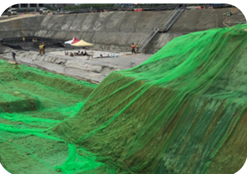
● 裸露地表鋪設防塵網，防止粉塵逸散之設施
