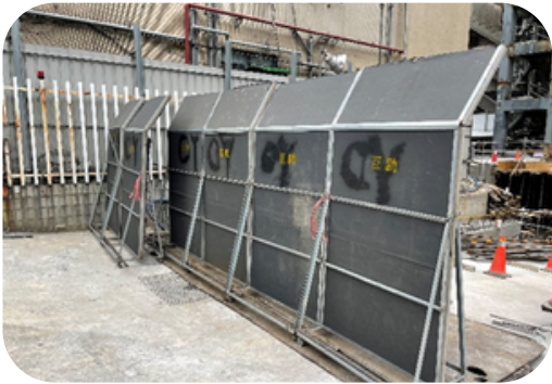
● 設置降噪設備
