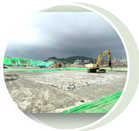
工地混凝土鋪面打除
