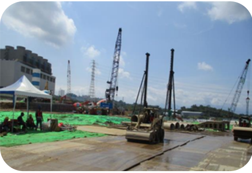
● 車行路徑鋪設鋼板
